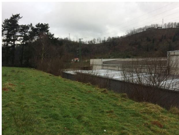
Imagen 5. Vista hacia el oeste. En primer plano, prado. Entre éste y la cubierta del pabellón, frondosas situadas en el talud.
