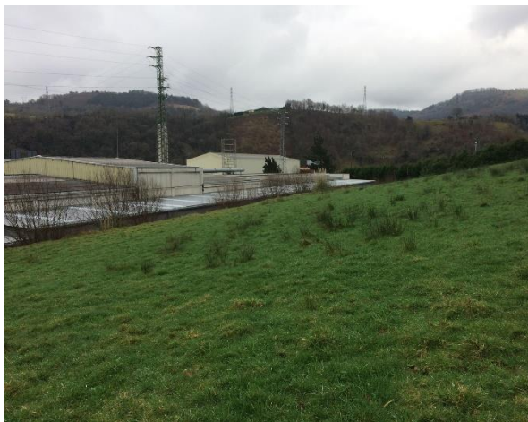
Imagen 4. Prado, vista hacia el este.
